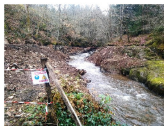
Ouvrage TATEN un mois après arasement
