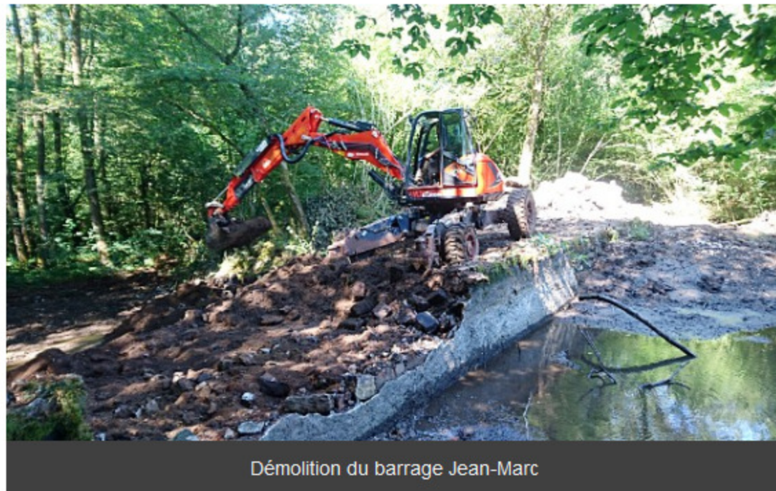
Démolition du barrage Jean-Marc.
