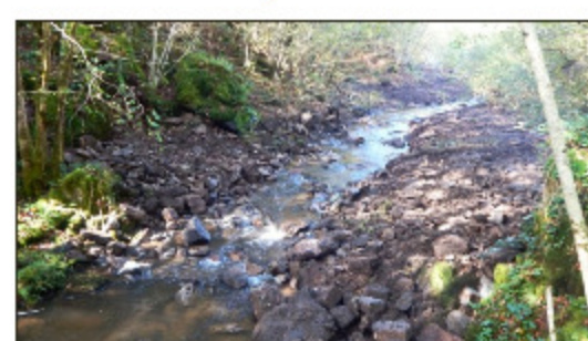
Après arasement et remodelage du lit mineur
