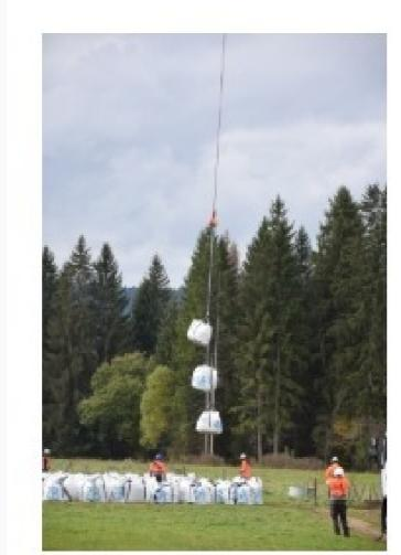
Le choix des hélicoptères se fait essentiellement en fonction du poids des matériaux à transporter. Nous avons travaillé avec des Ecureuils AS350 et des Super Puma. Ces deux modèles ont des capacités de charge très importantes, qui permettent d'approvisionner tout type de fournitures. Le modèle Ecureuil a une capacité de charge d'environ d'une tonne maximum, le Super Puma peut quant à lui aller jusqu'à 4 tonnes, selon certaines conditions.
