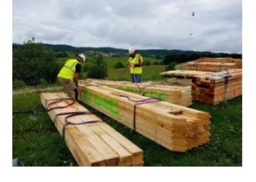
De plus, plusieurs de nos ouvriers sont formés à la préparation et au chargement à réaliser, et le service d'études interne élabore un plan d'héliportage avant chaque intervention. Ce plan permet de définir la répartition des charges et la localisation des approvisionnements. Ils sont transmis aux personnes qui effectuent l'héliportage avant le commencement de l'opération.
